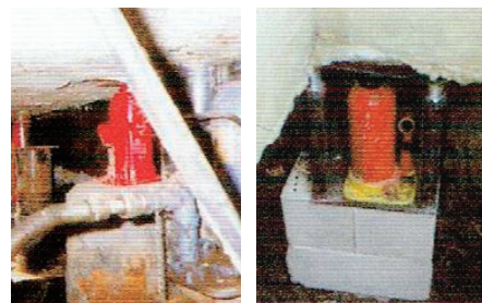
油圧ジャッキ取り付け作業
